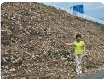
県道側道草刈り
