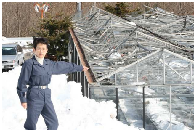
ビニールハウスが崩壊した現場にて。 あまりの光景に言葉が出ませんでした。
