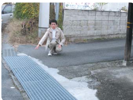
県道の整備（グレーチングの設置）
