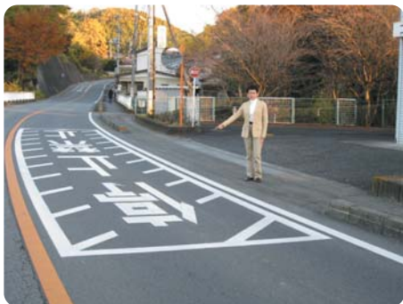
緊急車輛の出入口前に「停止禁止」の標示設置
